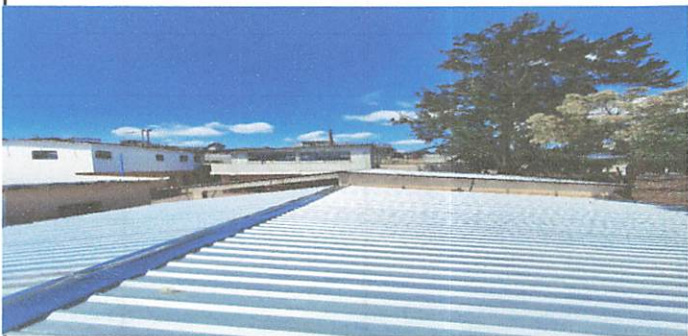
Foto1: ya realizado el cam bio de lamina con capote instalado
