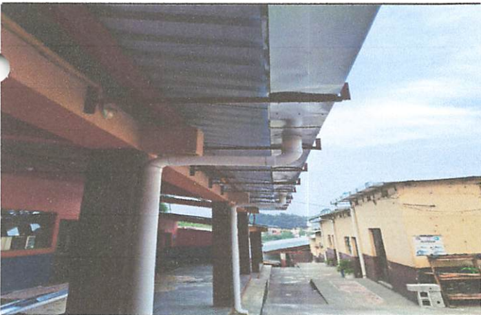
Foto1: ya realizado el cam bio de lamina con capote instalado
