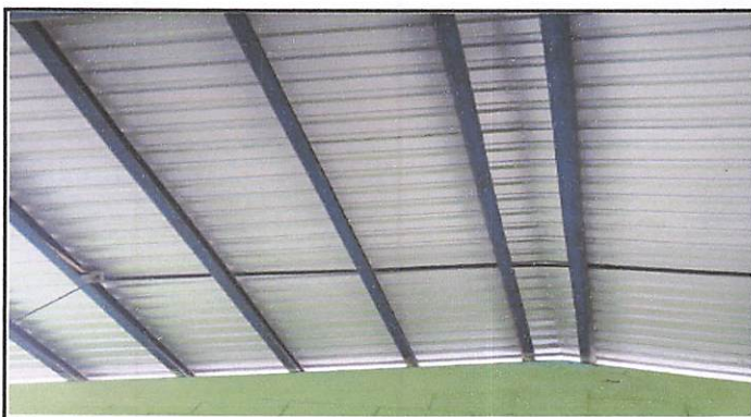
Foto 3: Techo nuevo de lámina troquelada terminado y colocado en los salones de clase y cocina .
