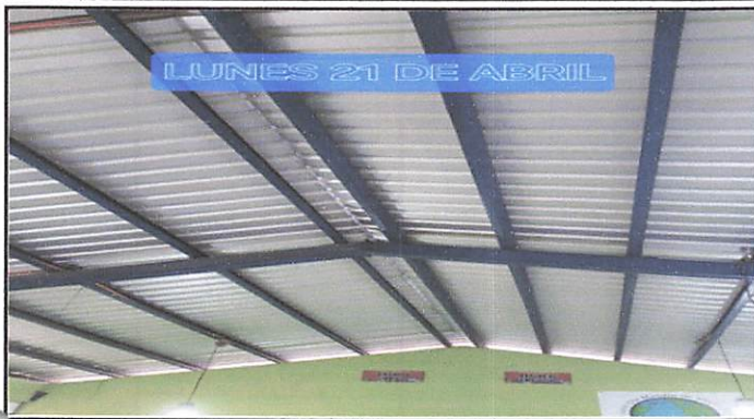
FOTO 1: Finalización de colocación de la lámina troquelada en los salones.
