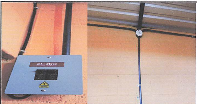
Foto 6: Caja de distribución que alimenta a los tomacorrientes y cableado de la cocina de la escuela, colocado y protegido.
