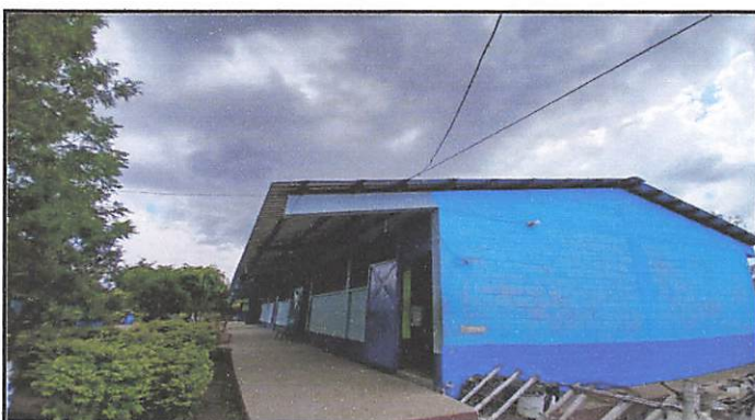
Foto 4: Panorámica del ala 1 del techo nuevo de lámina troquelada terminado y colocado .
