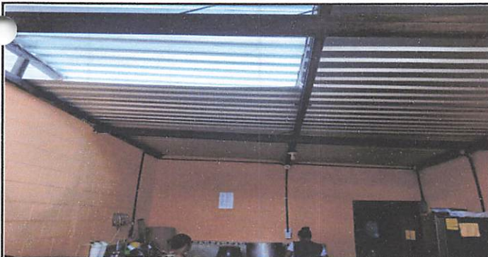
Foto 5: Caja de distribución y cableado instaladas.
