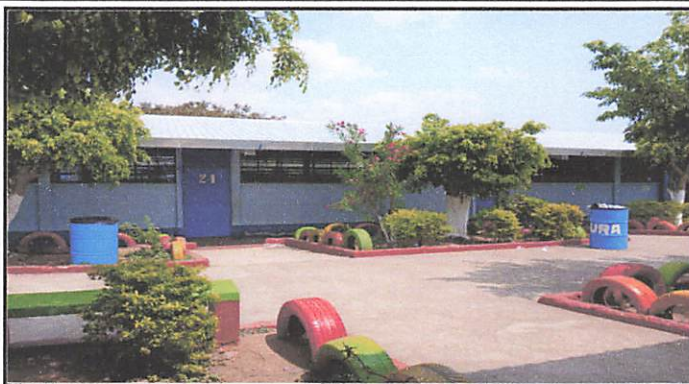
Foto 2: Techo nuevo de lámina troquelada terminado y colocado en el ala 2 de salones.
