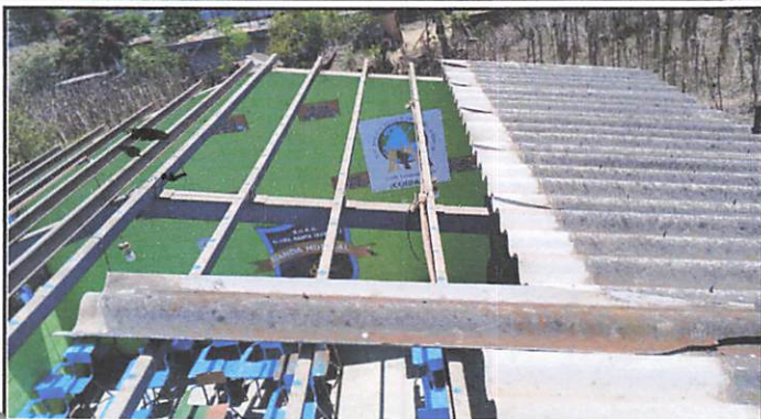
FOTO 1: Inicio del trabajo de dismantelación del techo de duralita, fotografía tomada de la parte superior del salón de clase.
