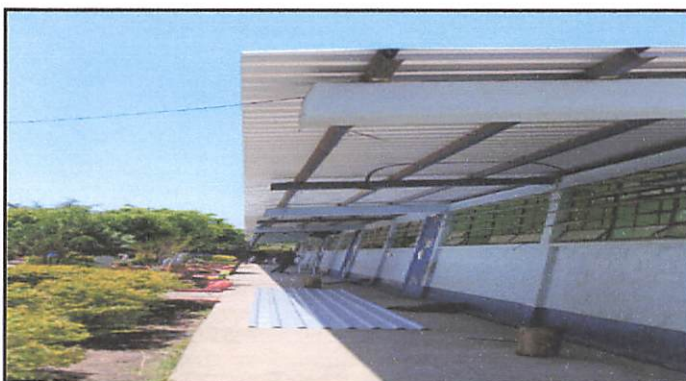
Foto 4: Colocación de ultimas láminas troqueladas en los salones de clase.
