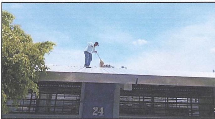
Foto 2: Avance de la revisión de la colocación de lámina troquelada.
