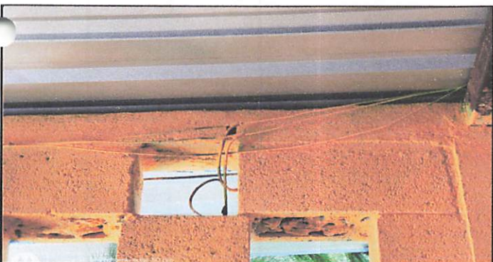
Foto 5: Avance del cambio de cableado en mal estado ya que se observan las uniones con cinta de aislar en la cocina.
