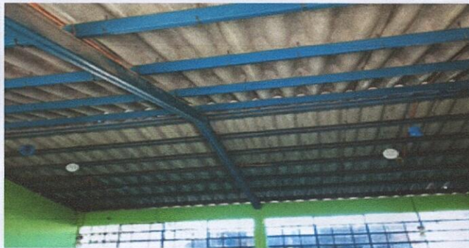
Foto1: LA FOTOGRAFIA MUESTRA EL TECHO DE TODOS LOS SALONES SON DE DURALITA Y SE SUSTITUIRA POR LAMINA TROQUELADA CALIBRE 26, SERAN 8 AULAS Y 1 DIRECCION.
