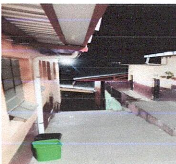
Sustitución de bajada de agua pluvial de metal por tubo PVC 3"
