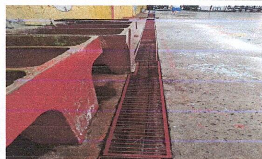
Sustitucion de tapas de concreto por rejas de metal en cancha
