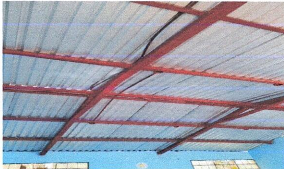
Mantenimiento a estructura de soporte de metal
