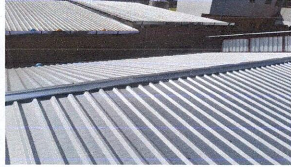
Sustitución de capote de lámina para lámina troquelada
