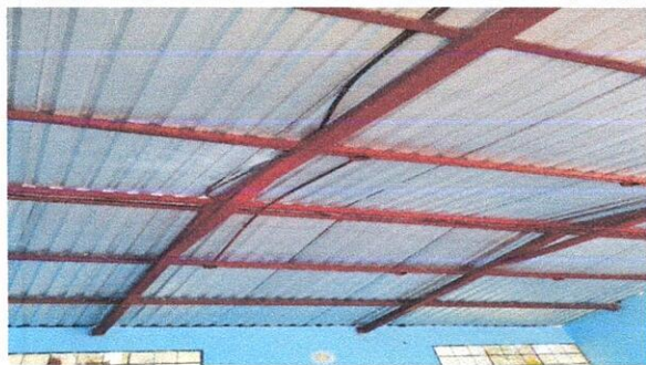
Sustitución de plafoneras en salones salones 1,2,3,4 y5 , pasillo y cancha
