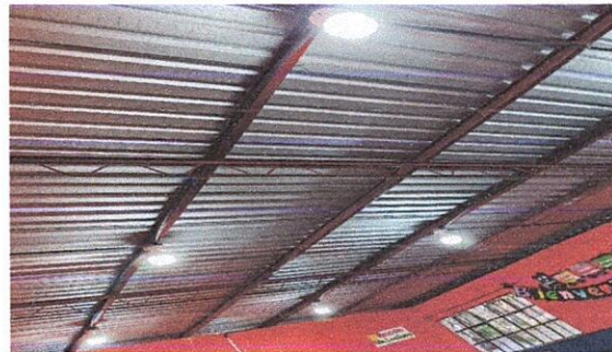
Reparación/Sustitución de cableado electrico
