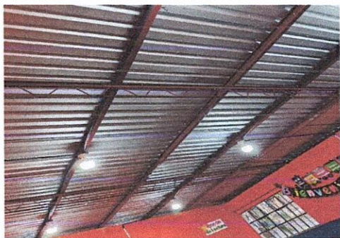
Sustitución de ducto eléctrico salones 1,2,3,4 y5 , pasillo, patio, gradas y cancha
