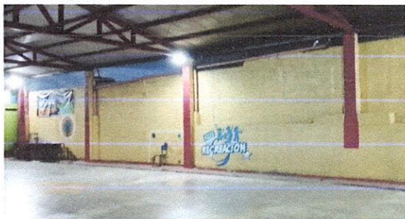
Sustitución de lamparas por reflectores en cancha, gradas y patio
