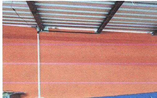
Instalación de canaletas en salones 1,2,3,4 y5 , pasillo
