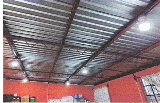
Sustitución de focos ahorradores salones 1,2,3,4,5,6,7,8 y corredor
