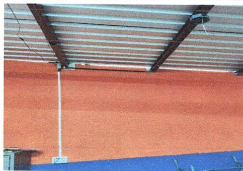
Instalación de tomacorrientes dobles en salones 1,2,3,4 y 5, pasillo y cancha
