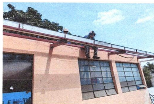
Sustitución de canal de metal
