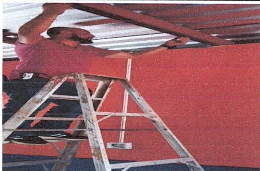
Sustitución de ducto eléctrico salones 1,2,3,4 y 5 , pasillo, patio, gradas y cancha
