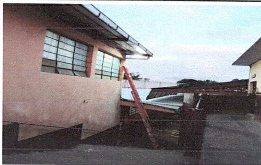
Sustitución de bajada de agua pluvial de metal por tubo PVC 3"
