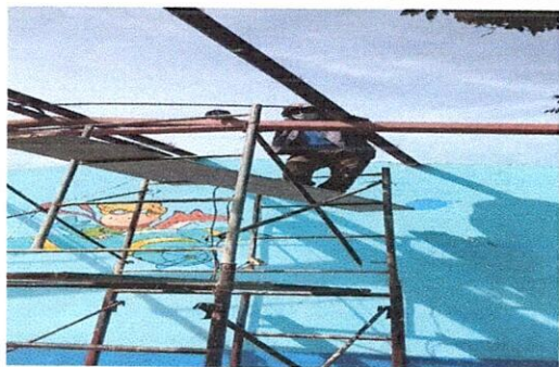
Mantenimiento a estructura de soporte de metal
