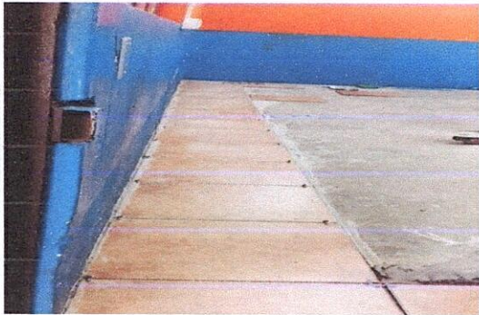
Instalación de 43 metros cuadrados piso cerámico en salón 1
