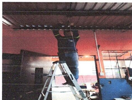
Reparación/Sustitución de cableado electrico
