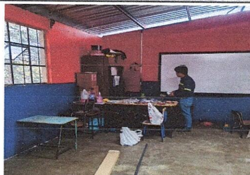
Instalación de canaletas en salones 1,2,3,4 y 5 , pasillo
