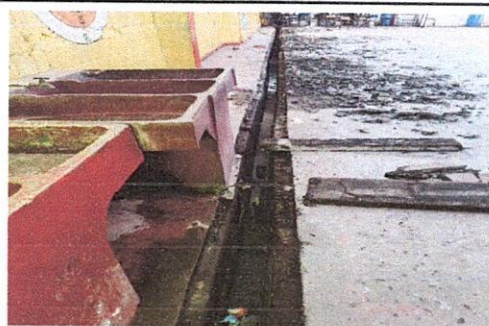
Sustitucion de tapas de concreto por rejas de metal en cancha
