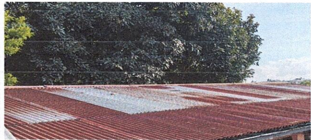
Sustitución de capote de lámina para lámina troquelada
