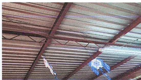
Reparación de cableado electrico
