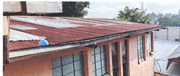
Sustitución de canal de metal
