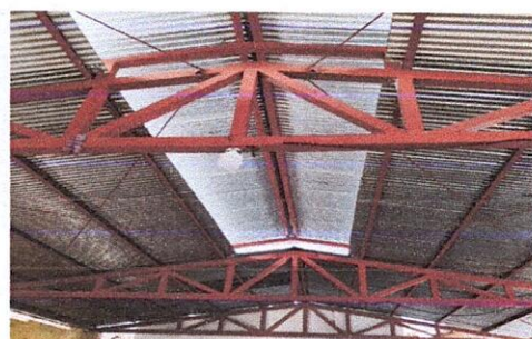
Sustitución de lamparas por reflectores en cancha, gradas y patio
