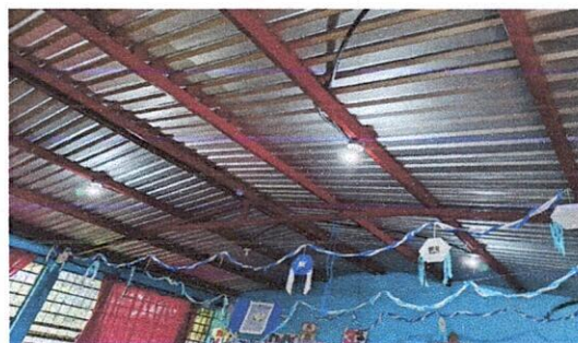
Sustitución de focos ahorradores salones 1,2,3,4,5,6,7,8 y corredor
