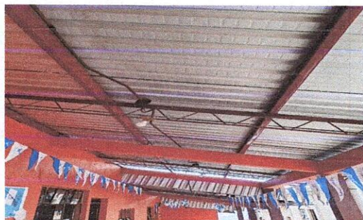
Sustitución de ducto eléctrico salones 1,2,3,4 y5 , pasillo, patio, gradas y cancha
