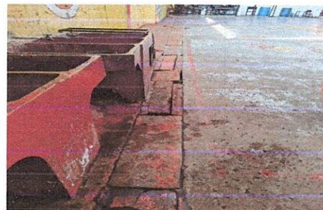
Sustitución de tapas de concreto por rejas de metal en cancha
