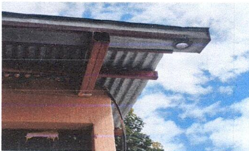
Sustitución de bajada de agua pluvial de metal por tubo PVC 3"
