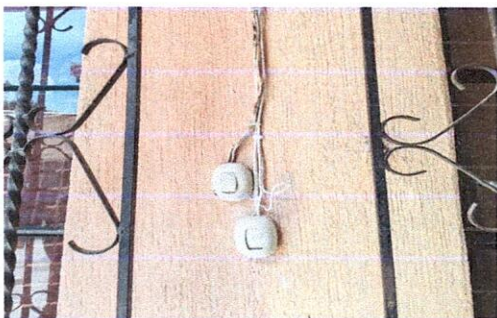
Sustitución interruptores dobles salones 1,2,3,4,5, corredor y cancha
