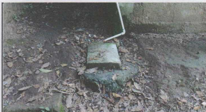
Foto 3: Excavación de fosa septica con caja de registro y biodigestor ya que la actual ya se va a llenar y se encuentra en un lugar muy lejano y no tiene biodigestor ni caja de registro para poder darle mantenimiento.
