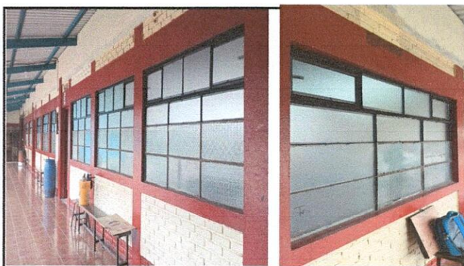
FOTO 4: CAMBIO DE VENTANAS DE LOS SALONES DEL 1 AL 9
