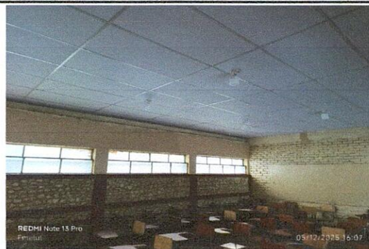
FOTO 2: COLOCACIÓN DE CIELO FALSO EN LOS SALONES DEL 1 AL 9
