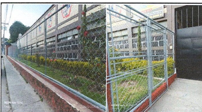
FOTO 3: DESMONTAJE Y COLOCACIÓN DE 161 MTS. DE MALLA METÁLICA
