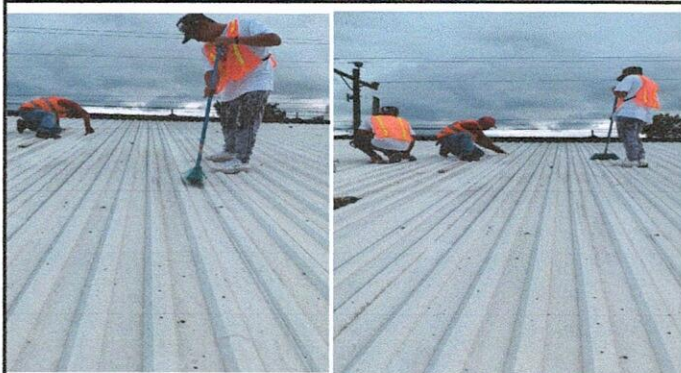
FOTO 1: REPARACIÓN DE FILTRACIONES DE TECHO
