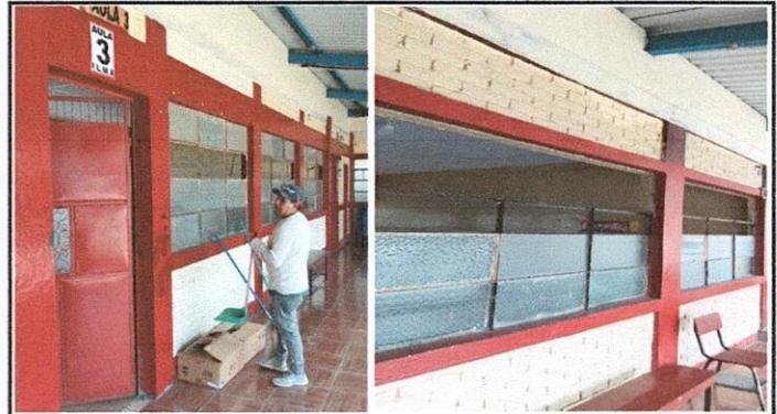
FOTO 4: CAMBIO DE VENTANAS DE LOS SALONES DEL 1 AL 9
