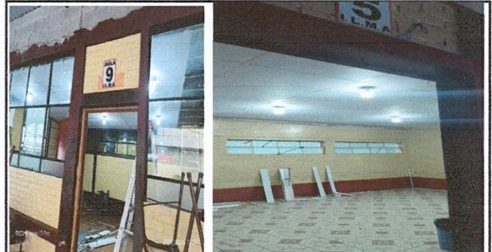
FOTO 6: DESMONTAJE DE 38 LÁMPARAS E INSTALACIÓN DE PLAFONERAS
