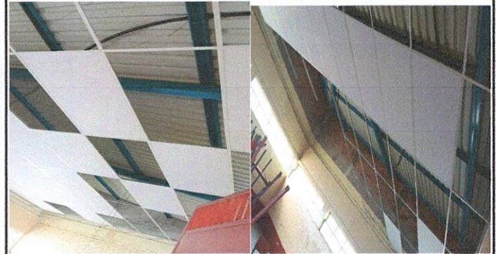
FOTO 2: COLOCACIÓN DE CIELO FALSO EN LOS SALONES DEL 1 AL 9
