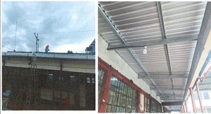
FOTO 1: REPARACIÓN DE FILTRACIONES DE TECHO
