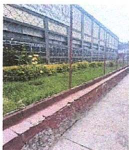
Desmontaje y colocación de 161 mts. de malla metálica
