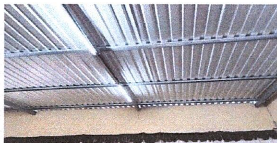
Colocación de cielo falso en los salones No. 1 al 9
