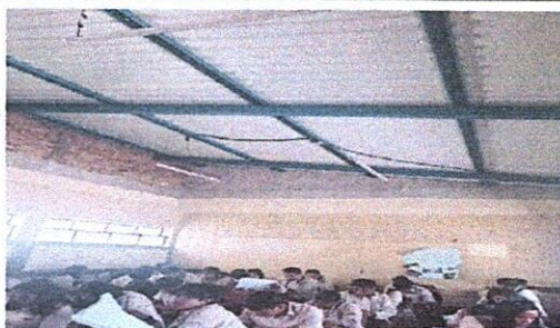
Reparación de filtraciones en techo de salones No. 1 al 9
