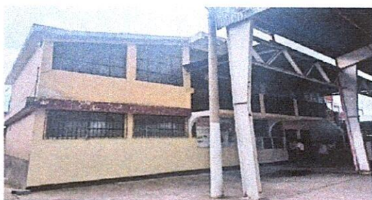
Pintura de 2 salones de computación
