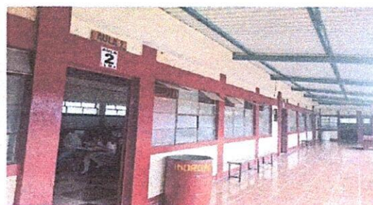
Cambio de ventanas de los salones 1 al 9
