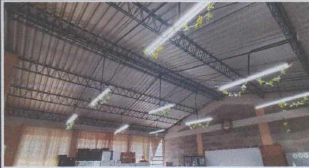
Foto 1: Taller de Alimentos, Cocina y Repostería, colocación de cielo falso
