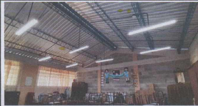
Foto 3: Taller de Corte y Confección, colocación de cielo falso
