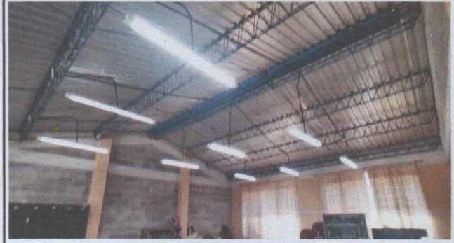
Foto 2: Taller de Belleza, colocación de cielo falso
