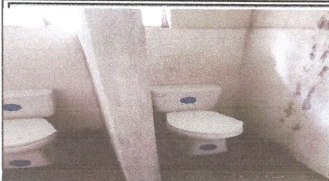
Foto 1: Cambio de Sanitarios
