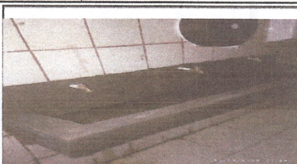
Foto 2: Quitar los lavamanos y hacer las piletas
