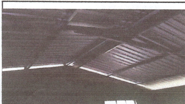
Foto 3: Quitar el cielo falso y laminado hacer la estructura nueva del laminado
