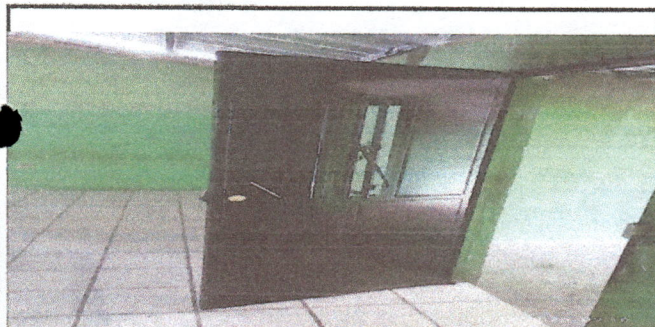
Foto 5: Reparación de puertas y reposición de puertas
