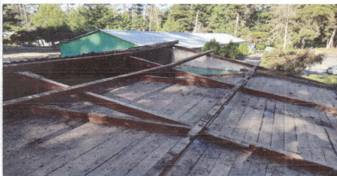
Foto 3: Quitar el cielo falso y laminado hacer la estructura nueva del laminado
