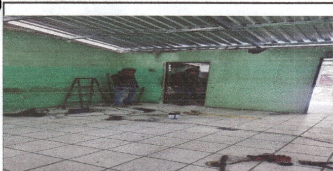
Foto 5: Reparación de puertas y reposición de puertas
