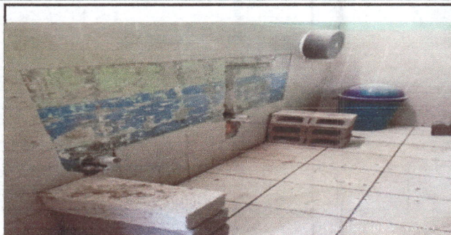
Foto 2: Quitar los lavamanos y hacer las piletas
