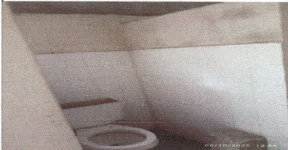
Foto 1: Cambio de Sanitarios
