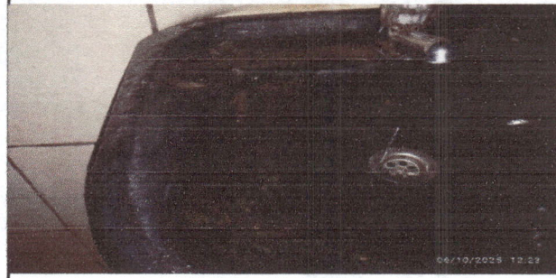
Foto 2: Quitar los lavamanos y hacer las piletas
