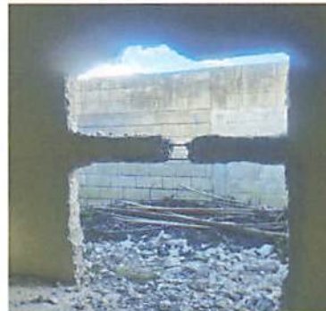
Foto 2: área de ampliación de cocina, lado atrás
