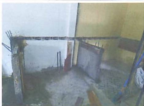
Foto 3: área de demolición de cocina de leña y fabricación de isla
