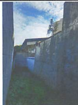
Foto 2: área de ampliación de cocina, lado atrás
