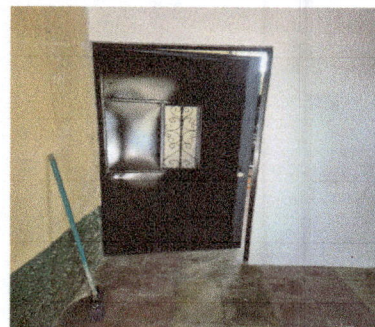
Foto 6: Puerta instalada y trabajo finalizado.
