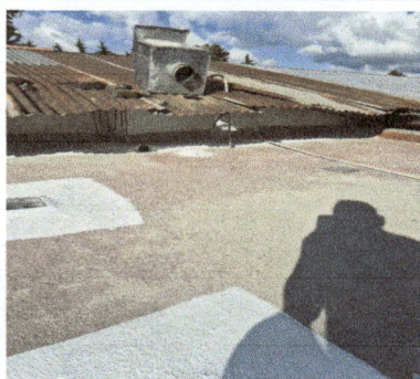
Foto 3: Blocks de vidrio cambiados e impermeabilizados.
