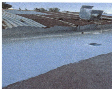
Foto 5: Impermeabilización de loza finalizada.
