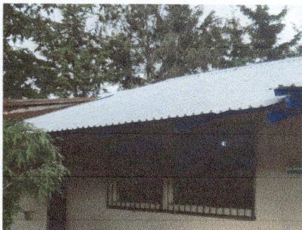
Foto 1: Techo de lámina instalado y terminado.
