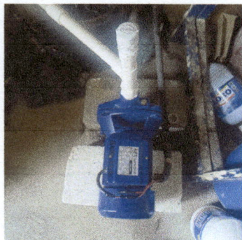
Foto1: Nueva bomba instalada y en funcionamiento.
