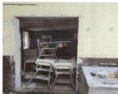
Foto 2: Elaboración de puerta para comunicar nuevo espacio de cocina terminado.
