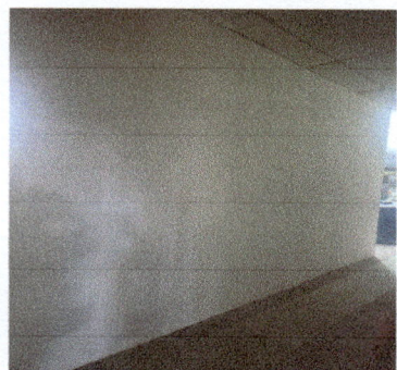
Foto 3: Otra vista de la parte exterior de la división con tabla yeso.
