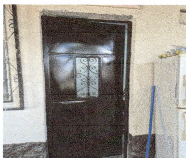
Foto 3: Nueva puerta instalada.
