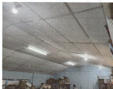
Foto 4: Cielo falso e instalación eléctrica terminada.
