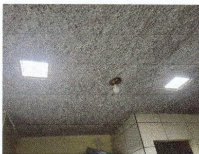
Foto 5: Blocks de vidrio cambiados.
