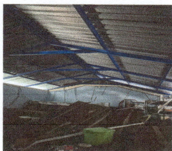
Foto 3: Tercho finalizado, vista de dentro del salón de clases.
