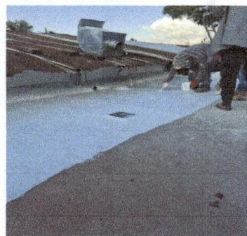
Foto 4: Realizando los últimos toques a la impermeabilización de loza.
