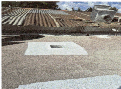
Foto 1: impermeabilización del repello que se colocó entre paredes para evitar la filtración de agua durante el invierno.
