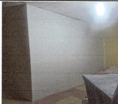
Foto 5: Parte posterior de la división con tabla yeso.
