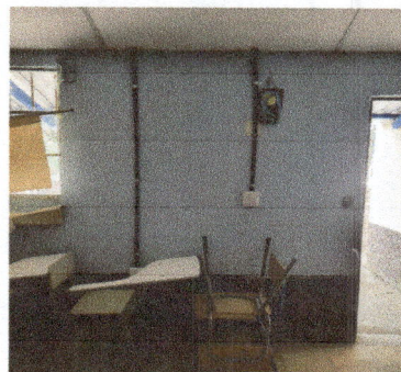
Foto 6: Varios toma corrientes e interruptores de luces instalados.
