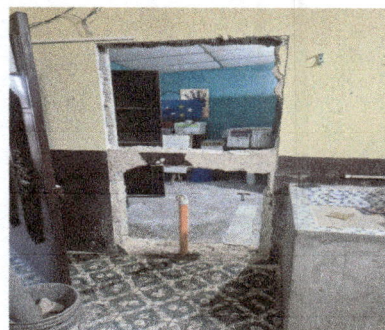
Foto 2: Apertura de puerta para ampliación de cocina.
