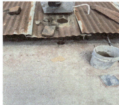
Foto 2: Eliminación del respiradero en la loza de la cocina.
