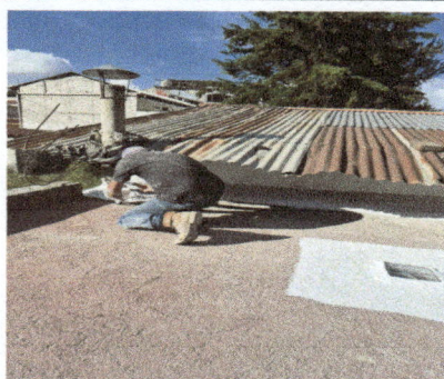
Foto 5: Inicio de impermeabilización.
