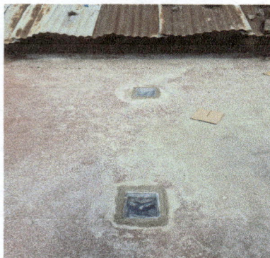
Foto 1: Cambio de bloques de vidrio en la loza de la cocina.
