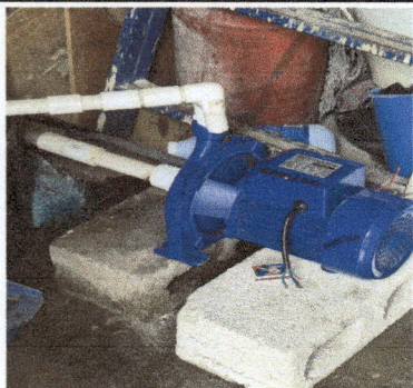
Foto1: Bomba en proceso de cambio.
