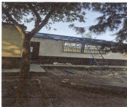
Foto 3: Estructura de metal completa para nuevo techo de lámina.
