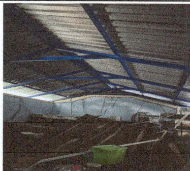
Foto 5: Techo de lamina y estructura de metal terminada.
