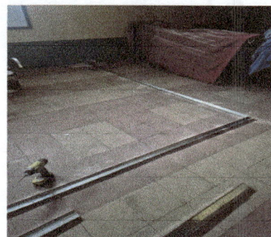
Foto 2: Colocación de riel para división con tabla yeso.
