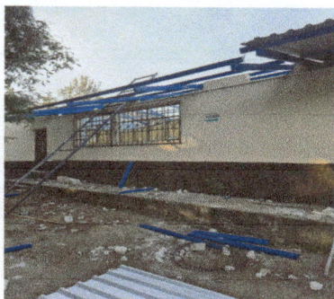
Foto 1: Inicio de instalación de vigas de metal.
