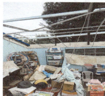
Foto 2: Seguimiento en el cambio de vigas de metal.
