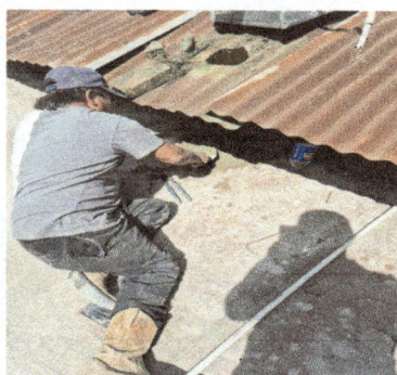
Foto 3: Eliminación del agujero donde se encontraba un respiradero en la loza.
