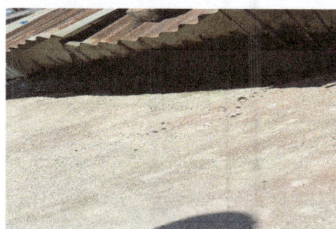
Foto 4: Colocación de repello para evitar filtración de agua entre paredes.
