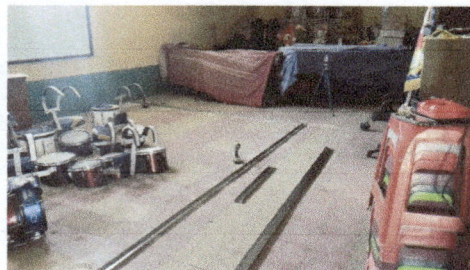
Foto 1: Inicio del trabajo de división con tabla yeso en el salón de música.
