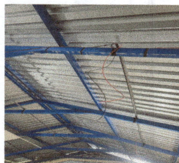
Foto 4: Techo de lámina instalado e inicio de cableado eléctrico.
