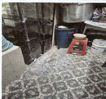
Foto 5: Cambio de blocks en techo de cocina.
