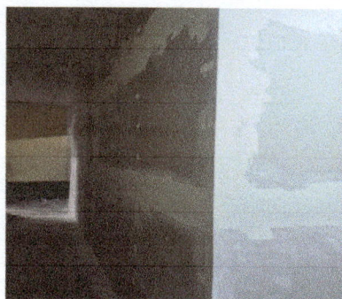
Foto 5: Terminado de división con tabla yeso por fuera.
