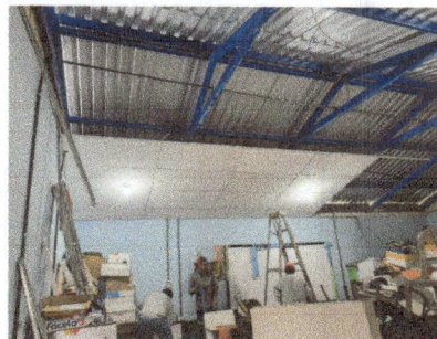
Foto 6: Instalación de tomacorrientes.
