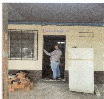
Foto 3: Instalación de nueva puerta con chapa.
