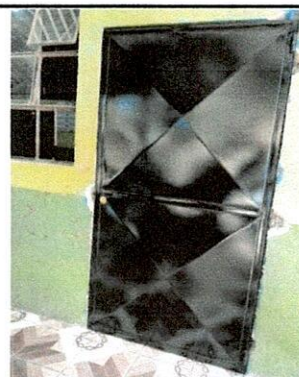
Foto 4: SE TERMINO DE COLOCAR LAS PUERTAS
