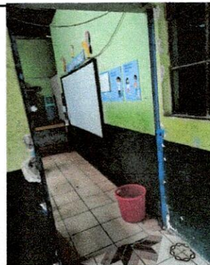
Foto 4: PROCESO DE SUSTITUCION DE LAS 2 PUERTAS
