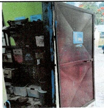
Foto 4: CAMBIO DE 2 PUERTAS
