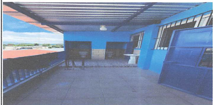
Foto 3: Finalizacion de Sanitarios
