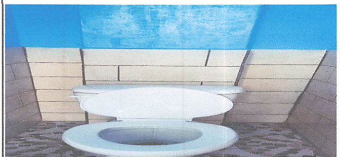
Foto 5: Colocacion de sanitarios
