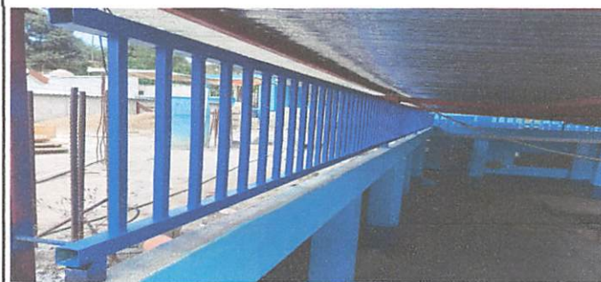
Foto 6: colocacion de barrandas
