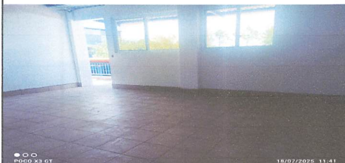
Foto 1: Finalizacion de Blanqueado y colocacion de Piso
