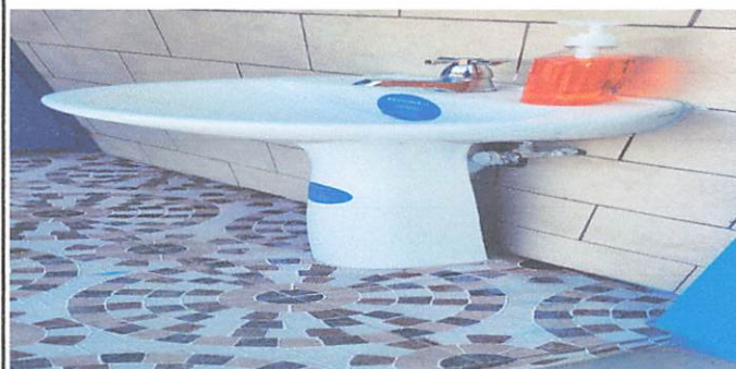
Foto 4: Finalizacion de Lava manos
