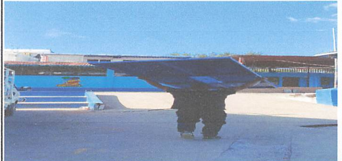
Foto 8: instalacion de puerta
