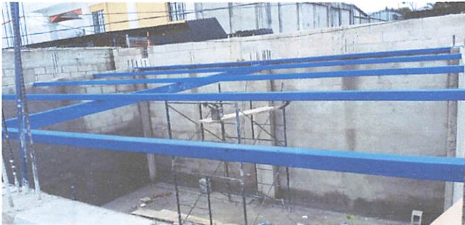
Foto 3: colocacion de costaneras
