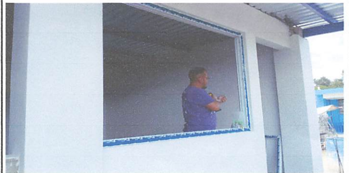
Foto 10: colocacion de ventana PVC
