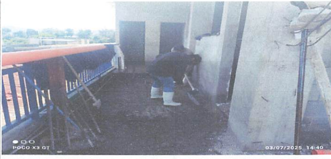
Foto 7: colocacion de torta
