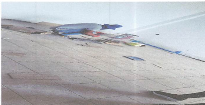
Foto 9: Instalacion de Piso
