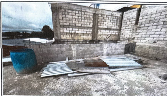
Foto 2: terminación de columnas
