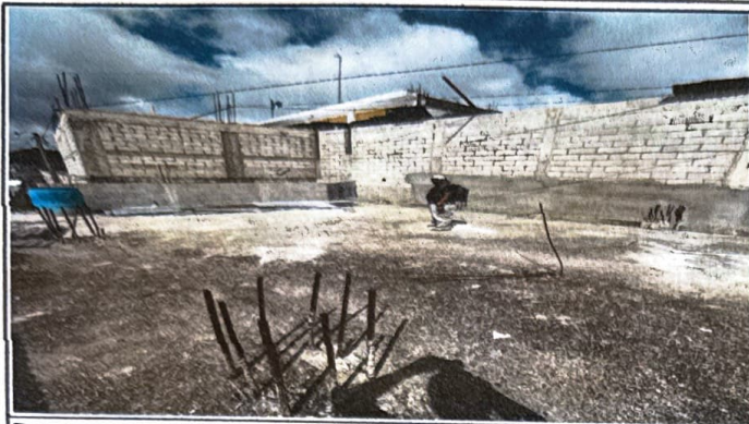
Foto 1: terminación de paredes
