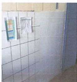
Foto 5: COCINA : Finalización de Colocación de azulejo en la cocina.
