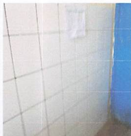
Foto 5: COCINA : Finalización de Colocación de azulejo en la cocina.
