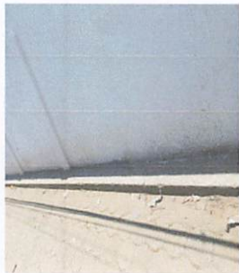
Foto1: BANQUETA. Finalización de fundición de banqueta y cernido.
