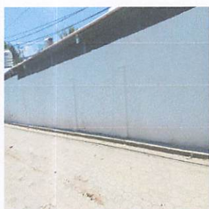
Foto1: BANQUETA. Finalización de fundición de banqueta y cernido.
