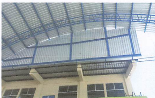
Foto 4: VACIO EN EL TECHO: Finalización en la colocación de láminas en el vacío y colocación de canales.
