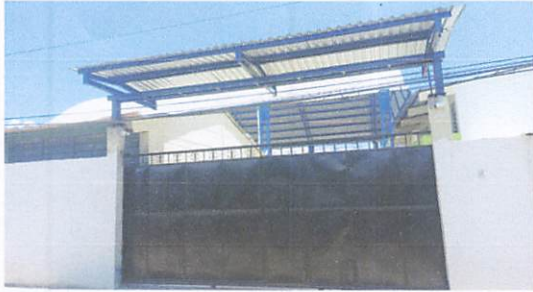
Foto7: Finalización del techado del porton de dos aguas.
