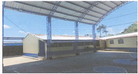
Foto 8: Salón 1 y 2: Finalización del cambio de lamina frente a los salones ya mencionados.
