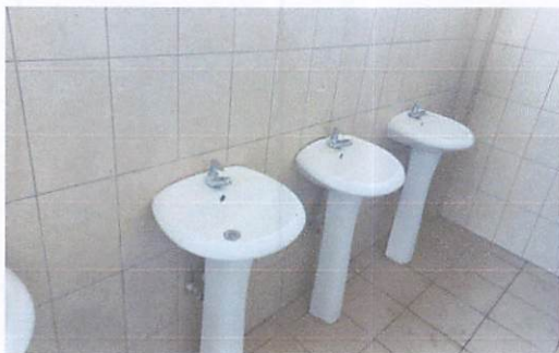
Foto 3: Baños del segundo nivel: Finalización de reparación de lavamanos, cambio de accesorios en los sanitarios y mijitorios.
