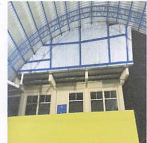
Foto 4: VACIO EN EL TECHO: Colocación de de laminas en el vacio y colocación de canales.
