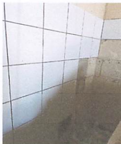
Foto 5: COCINA : Colocación de azulejo en la cocina.
