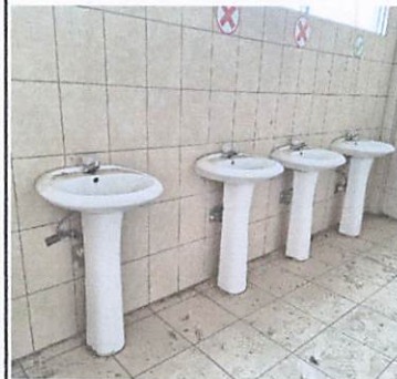
Foto 3: Baños del segundo nivel: Cambio de llaves de lavamanos y cambio de accesorios en los sanitarios y mijitorios.
