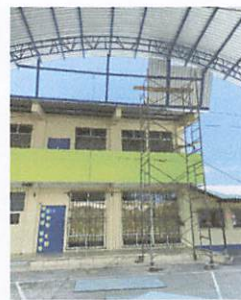
Foto 4: VACIO EN EL TECHO: Colocación de de laminas en el vacio y colocación de canales.
