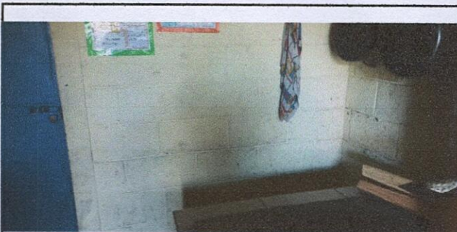
Foto 5: COCINA : Colocación de azulejo en la cocina.
