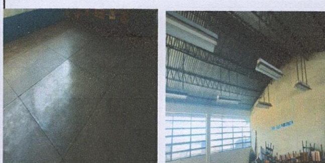
Foto 2: SALÓN: Colocación de piso salón 2, 12 y cambio de lamparas.
