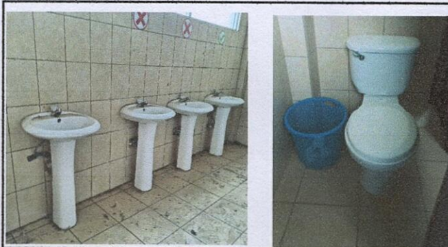
Foto 3: Baños del segundo nivel: reparación de lavamanos, cambio de accesorios en los sanitarios y mijitorios.
