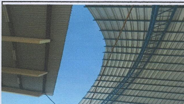
Foto 4: VACIO EN EL TECHO: Colocación de de laminas en el vacio y colocación de canales.
