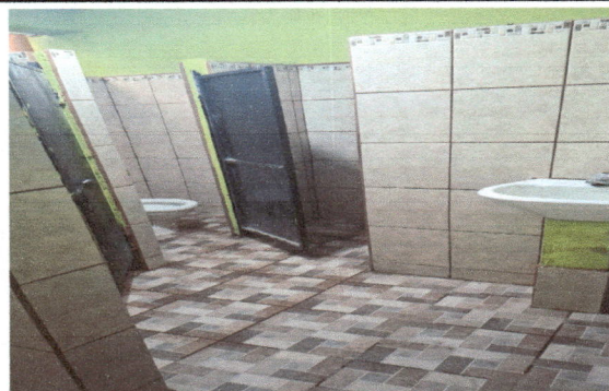
Foto 5: Instalación de piso antideslizante y cerámico en sanitarios.
