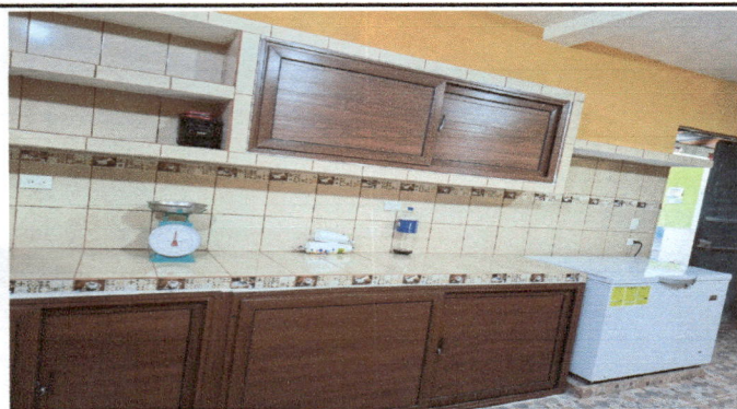
Foto 3: Pintura y repello de la cocina.
