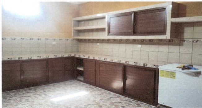
Foto 1: Culminación de estantería terrestre y repisa aérea con puertas deslizantes de pvc, piso cerámico antideslizante.
