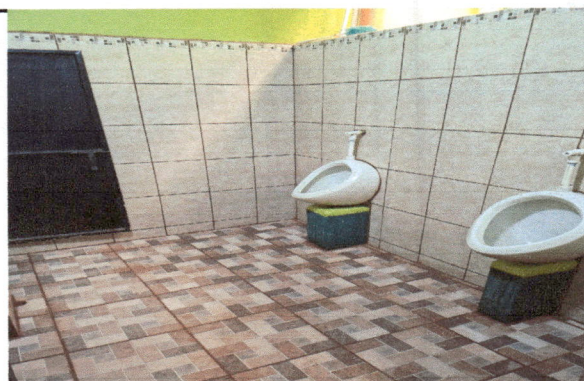
Foto 4: Instalación de piso antideslizante y cerámico en sanitarios.
