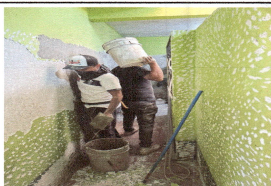
Foto 4: Picado y cernido en paredes de baños
