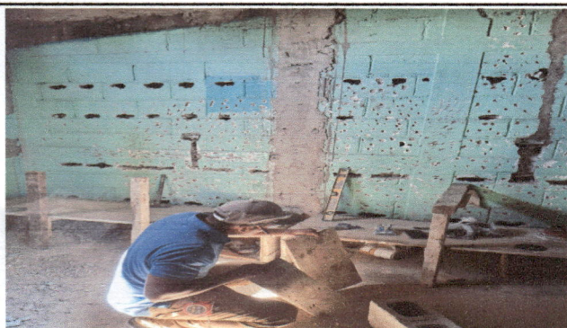
Foto 3: Elaboración de Repisa aérea perforación de pared anclaje y armadura
