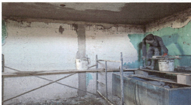
Foto 1: Picado y cernido en paredes y repello en loza
