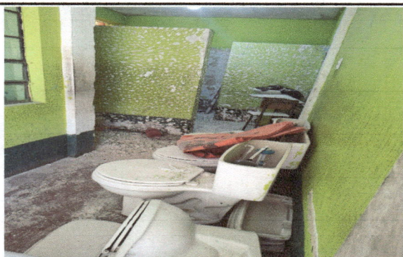
Foto 5: Desinstalación de los servicios sanitarios para la colocación de piso antideslizante.
