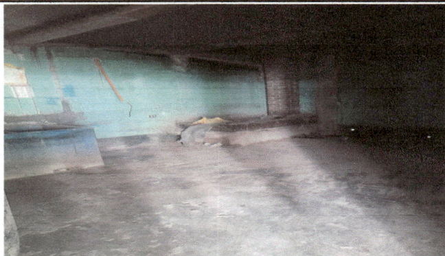
Foto1: Se prioriza en cocina cambio de piso cerámico, y elaboración de estantería terrestre y aéreo.
