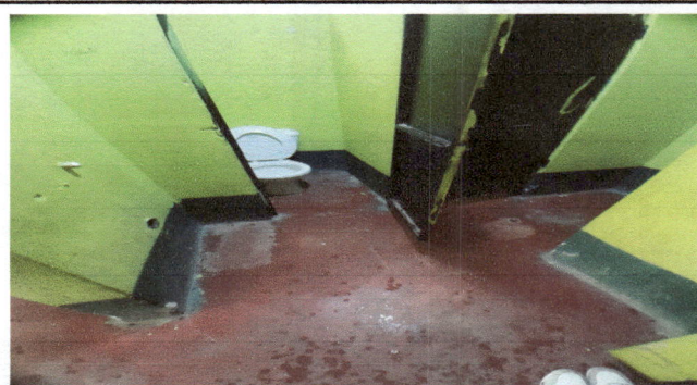
Foto 6: Desmontaje de sanitarios para la colocación de piso antideslizante
