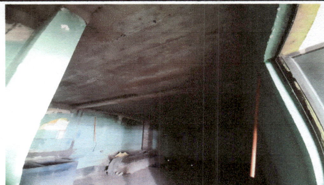
Foto 2: Aplicación de repello y cernido en loza de la cocina
