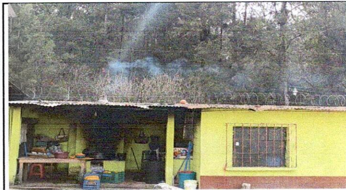
Foto 4: CAMBIO DE TECHO
