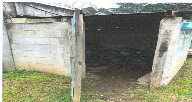
Foto 5: Remozamiento del área de bodega para basura
