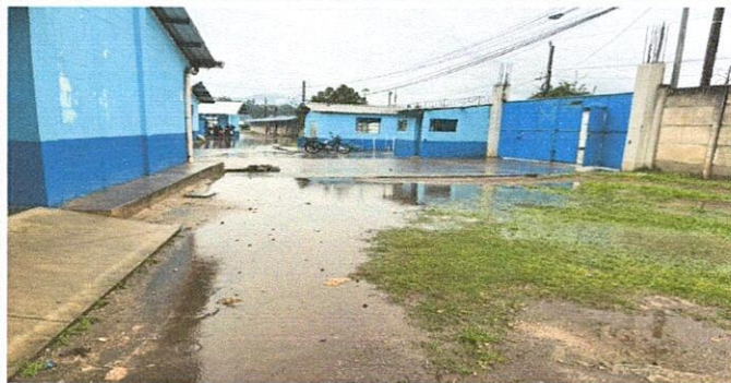
Foto1: Aguas de lluvia acumuladas dentro del plantel educativo: Módulos 1, SUM y calle. Instalación de tubería PVC, cajas de registro y rejilla.
