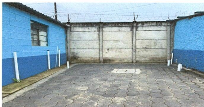
Foto 3: Elaboración de pila con tres lavaderos e instalación de sanitario para mejorar la limpieza general del plantel educativo.
