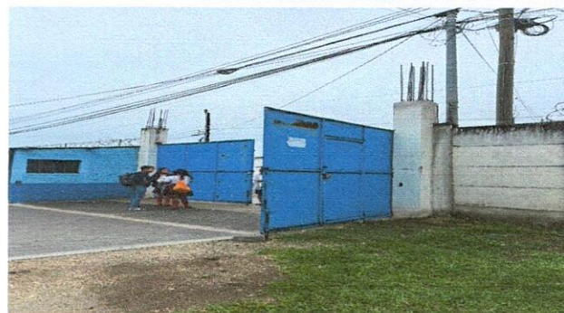
Foto 4: Techado de la entrada principal del portón, incluye iluminación y remozamiento del mismo.
