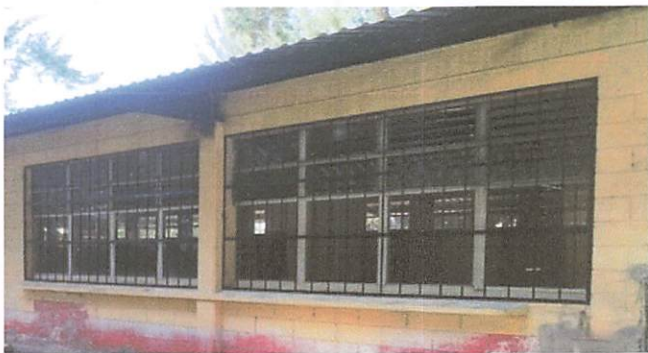
Foto 3: seguridad para el mobiliario y productos para cocinar con la instalacion de balcones en ventanas de cocina y comedor
