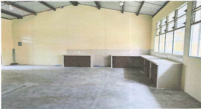
Foto1: Sustitucion area de cocina, lavatrastos, muebles de cocina de concreto con mesa para elaborar los alimentos
