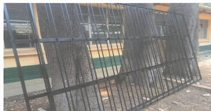
Foto 3: seguridad para el mobiliario y productos para cocinar con la instalacion de balcones en ventanas de cocina y comedor
