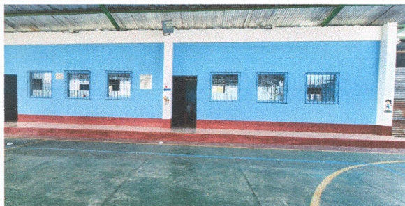
Foto 11: Pintura en muros exteriores de 3 aulas.
