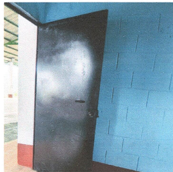
Foto 2: Mantenimiento a estructuras de puerta de metal con chapa.
