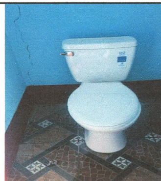
Foto 6: Sustitución e instalación de inodoros.
