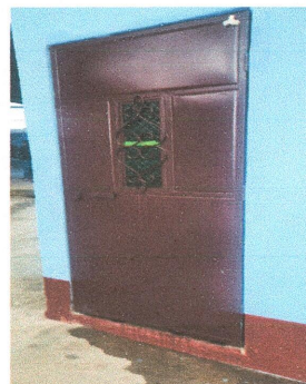
Foto 8: sustitución de puertas de servicio sanitario con chapa.
