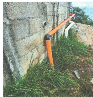
Foto 12: Sustitución de tubos de drenaje.
