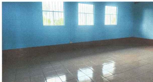
Foto 4: sustitución de piso por ceramico aula 2.
