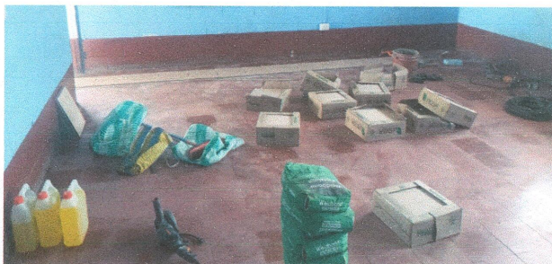
Foto 5: Sustitución de piso por ceramico aula 3.
