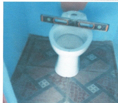
Foto 6: Sustitución e instalación de inodoros.
