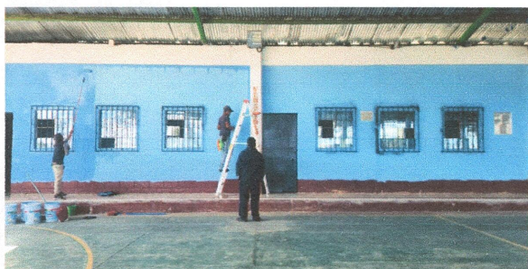
Foto 11: Pintura en muros exteriores de 3 aulas.
