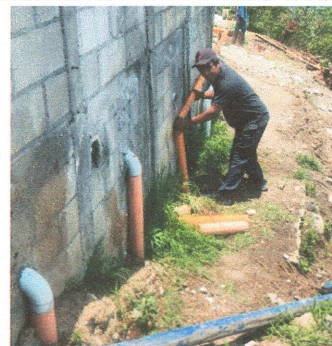
Foto 12: Sustitución de tubos de drenaje.
