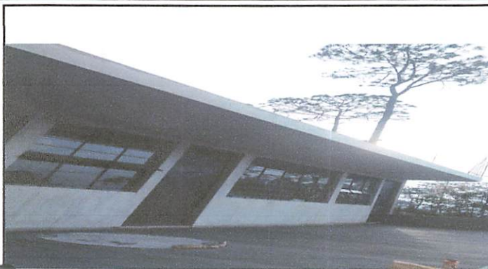
Foto 1: Reparacion y cernido de techo exterior
