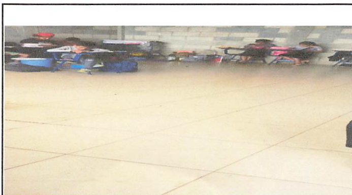
Foto 4: Instalacion de piso en salones 1 y 2
