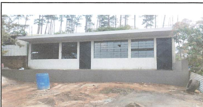
Foto 6: nivelacion de patio en salones 1 y 2
