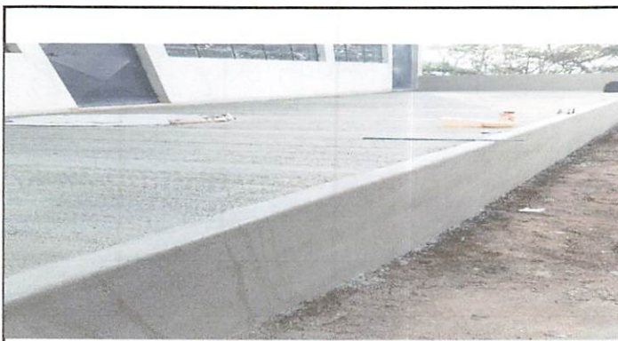
Foto 3: Relleno y nivelacion de patio de salones 1 y 2
