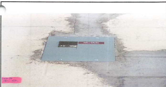
Foto 5: instalacion de caja de flipones
