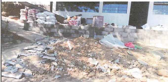
Foto 6: nivelación de patio en salones 1 y 2
