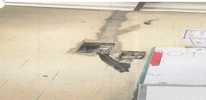
Foto 5: instalación de caja de flippers
