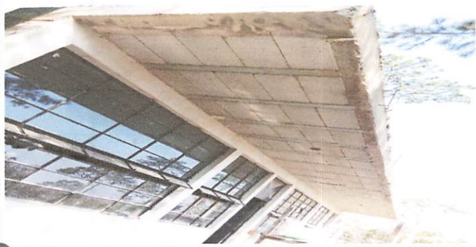
Foto 1: Reparación y cernido de techo exterior
