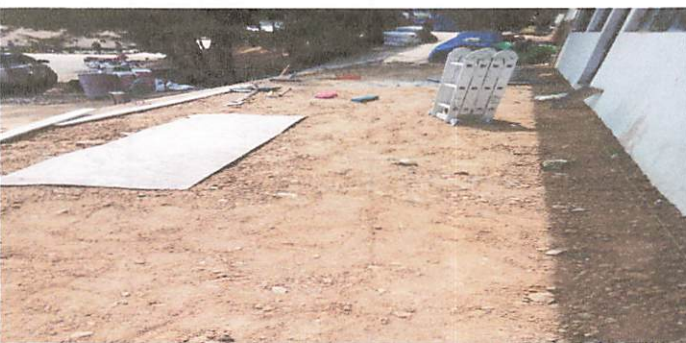
Foto 3: Relleno y nivelación de patio de salones 1 y 2
