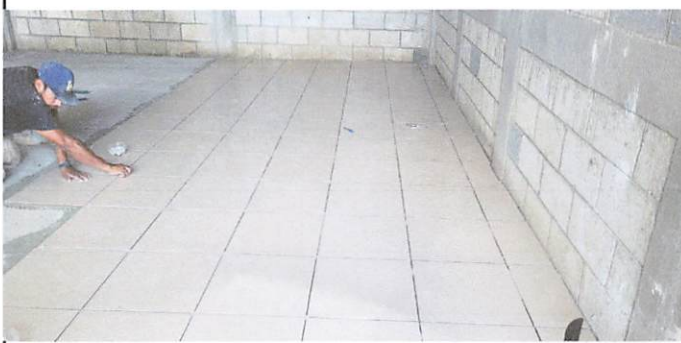
Foto 4: Instalación de piso en salones 1 y 2
