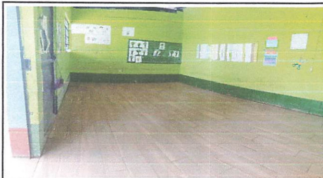
Foto 3: Instalación de piso tipo duela, módulo 1
