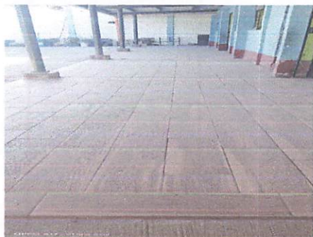
Foto1: Instalación de piso tipo duela, módulo 1
