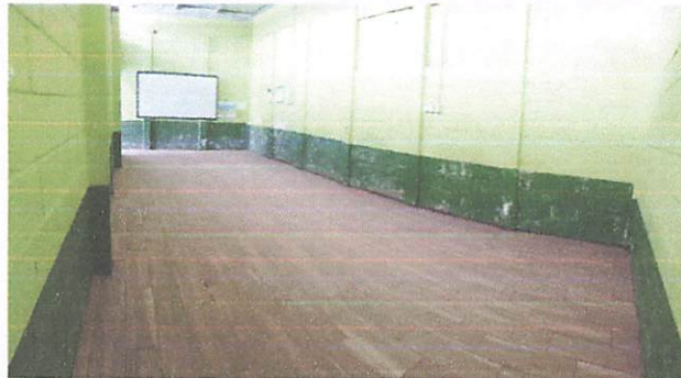
Foto 2: Instalación de piso tipo duela, módulo 1
