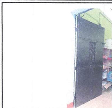
Foto 1: Instalación de 4 puertas del módulo 1
