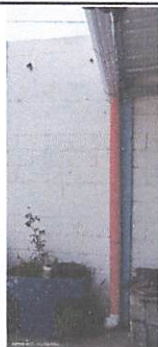
Foto 5: Instalación de canales y bajadas de aguas pluviales, módulo 1 y 2
