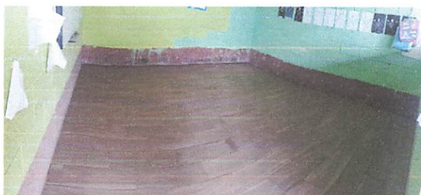
Foto 4: Instalación de piso tipo duela, módulo 1
