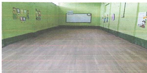
Foto 5: Instalación de piso tipo duela, módulo 1
