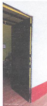
Foto 2: Instalación de 4 puertas del módulo 1
