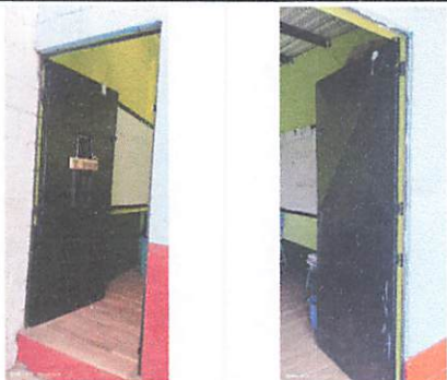
Foto 3: Instalación de 4 puertas del módulo 1
