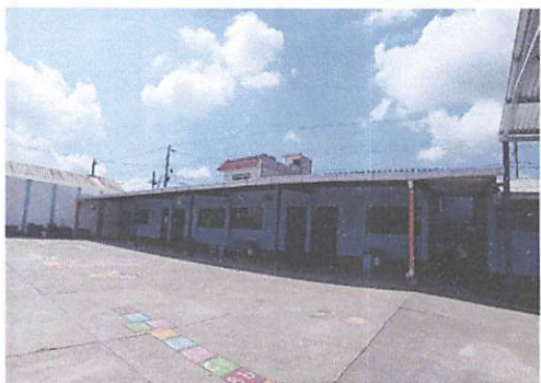
Foto 3: Instalación de canales y bajadas de aguas pluviales, módulo 1 y 2
