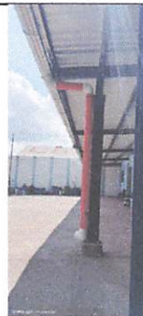
Foto 6: Instalación de canales y bajadas de aguas pluviales, módulo 1 y 2
