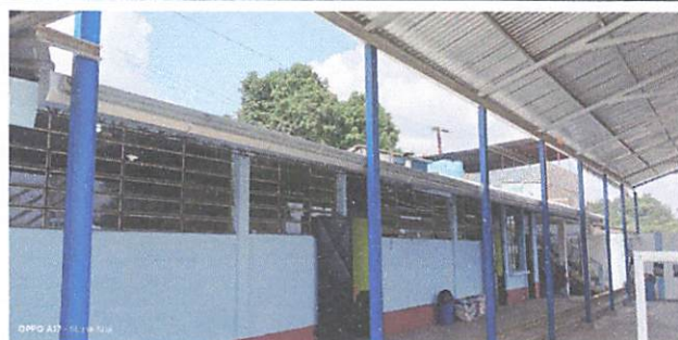
Foto 4: Instalación de canales y bajadas de aguas pluviales, módulo 1 y 2
