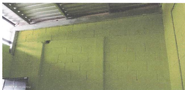
Foto 4: Salones pintados por deterioro.
