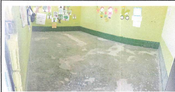
Foto 1: Reparación de base para instalación de piso tipo duela en módulo 1
