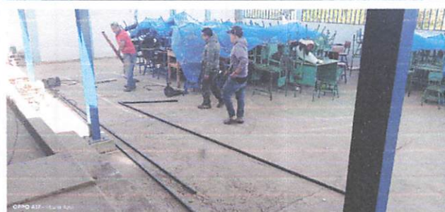
Foto 3: Colocación de canales y bajadas de aguas pluviales, módulo 1 y 2
