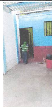
Foto 2: Instalación de las 4 puertas
