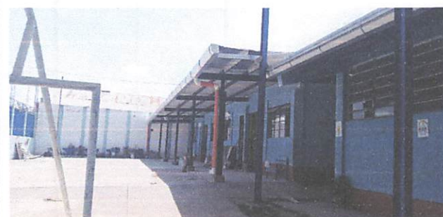
Foto 5: Colocación de canales y bajadas de aguas pluviales, módulo 1 y 2
