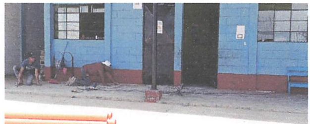
Foto 4: Instalación del piso tipo duela en módulo 1
