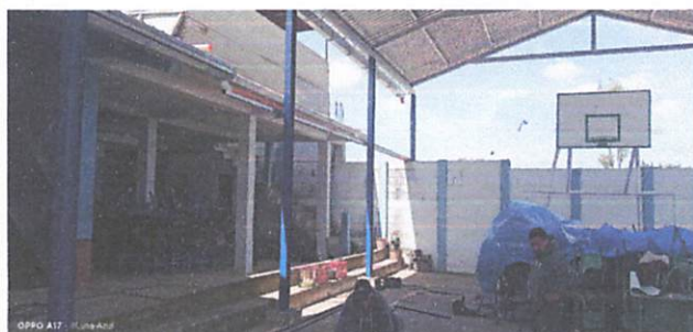
Foto 4: Colocación de canales y bajadas de aguas pluviales, módulo 1 y 2
