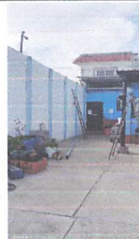
Foto 2: Cambio de estructura metálica y lámina, pasillo 1 y 2
