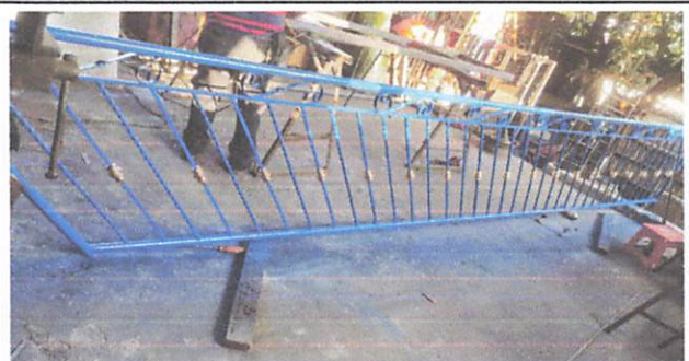
Foto 6: Elaboración de baranda
