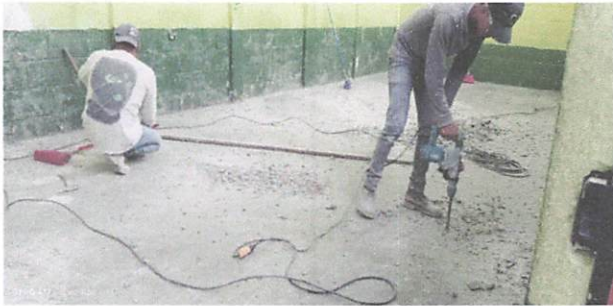
Foto 3: Reparación de base para instalación de piso tipo duela en módulo 1
