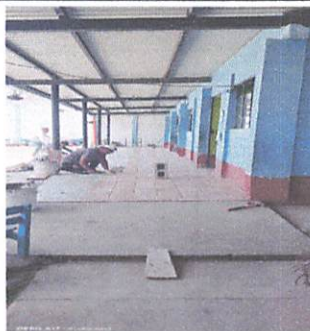
Foto 5: Instalación del piso tipo duela en módulo 1
