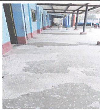
Foto 2: Reparación de base para instalación de piso tipo duela en módulo 1
