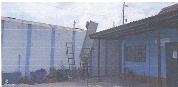
Foto 1: Cambio de estructura metálica y lámina, pasillo 1 y 2
