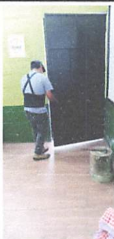
Foto1: Instalación de las 4 puertas
