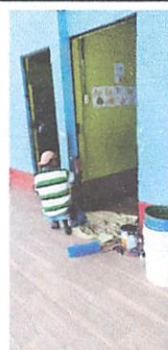
Foto 4: Instalación de las puertas del módulo 1.
