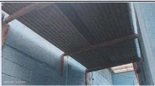
Foto 4: Cubierta de lámina. Sustitución de cubierta de techo y costaneras pasillo 1 y 2
