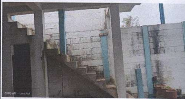
Foto 7: Mantenimiento de barandas. Instalación de barandas para seguridad de los estudiantes que reciben clases en el salón del segundo nivel.
