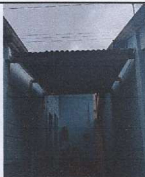
Foto 3: Cubierta de lámina. Sustitución de cubierta de techo y costaneras pasillo 1 y 2
