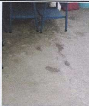
Foto 9: Piso: cambio de piso en el módulo 1 de la escuela por deterioro.
