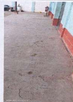
Foto 8: Piso: cambio de piso en el módulo 1 de la escuela por deterioro.
