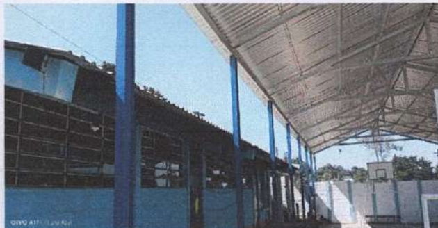
Foto 2: Instalación de canales y bajadas de agua
