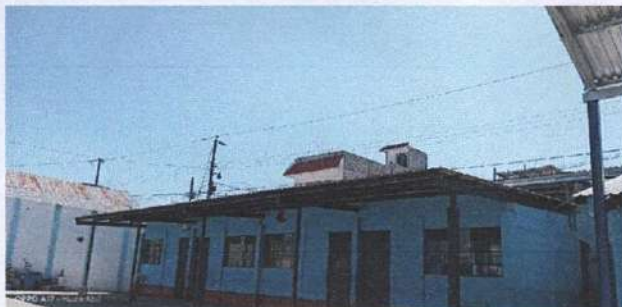
Foto1: Instalación de canales y bajadas de agua
