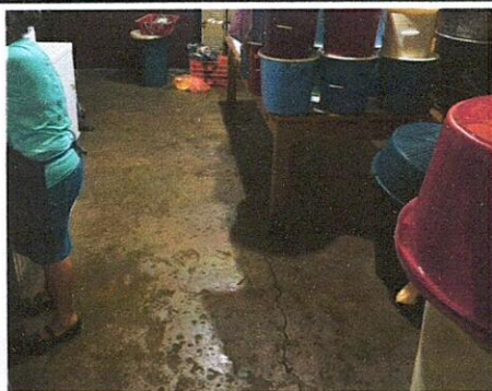
Foto 5: Situacion actual del piso de la cocina
