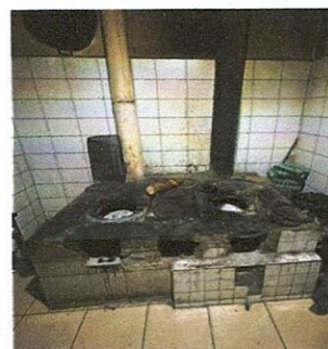
Foto 6: Vista de hoguera en mal estado y falta de chimenea
