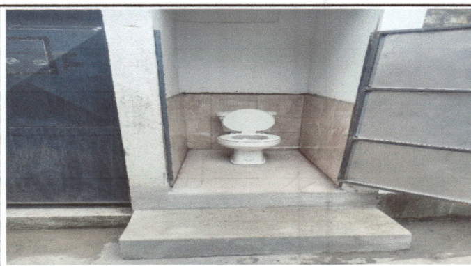
Foto 4: REPARACION DE SANITARIOS
