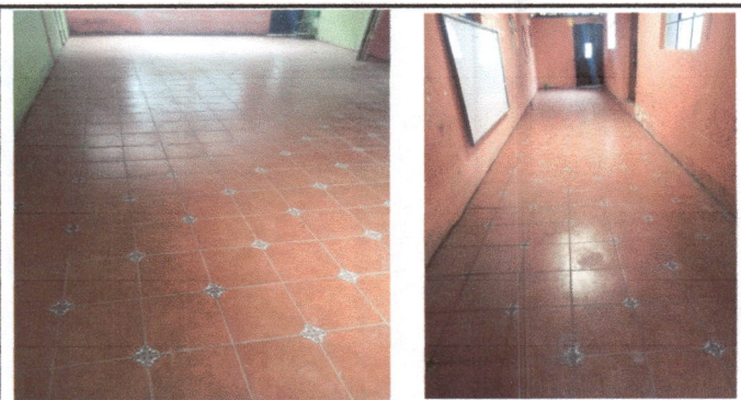
Foto 6: REPARACION DE PISO DE GRANITO
