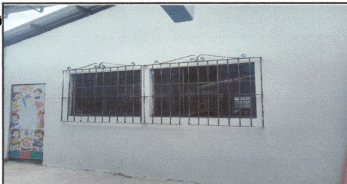
Foto 5: REPELLADO DE PARED
