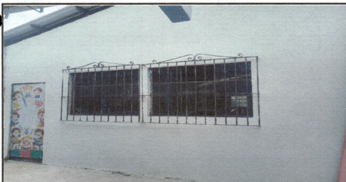
Foto 5: REPELLADO DE PARED
