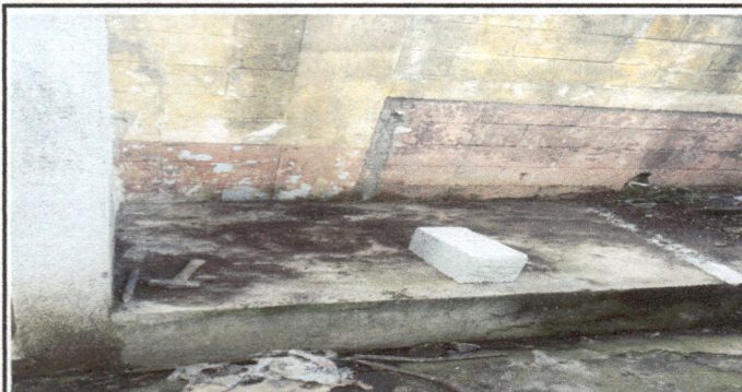
Foto1: SUSTITUCION DE PILA
