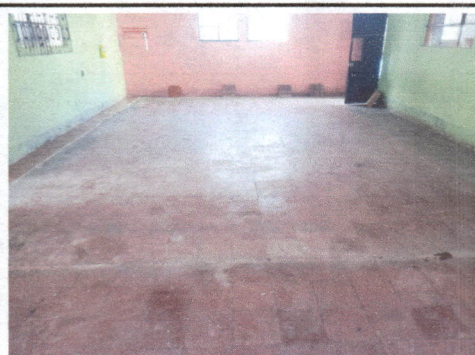
Foto 2: REPARACION DE PLANCHA DE CONCRETO DE PATIO
