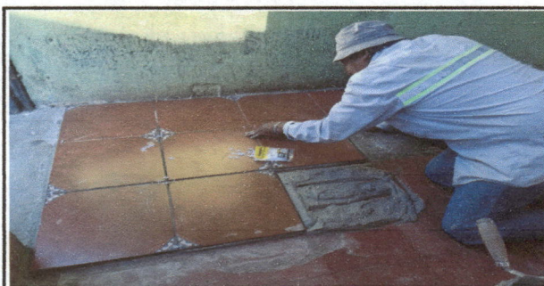
Foto 3: CUBRIMIENTO DE PATIO
