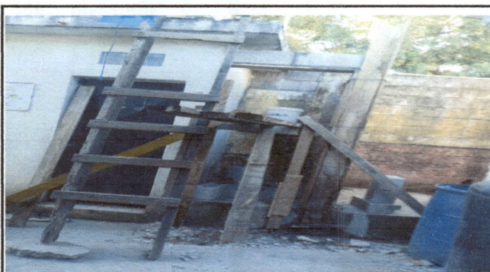
Foto 4: REPARACION DE SANITARIOS
