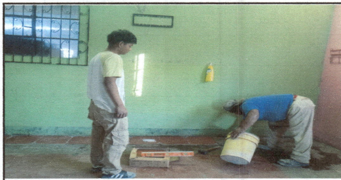
Foto 6: REPARACION DE PISO DE GRANITO
