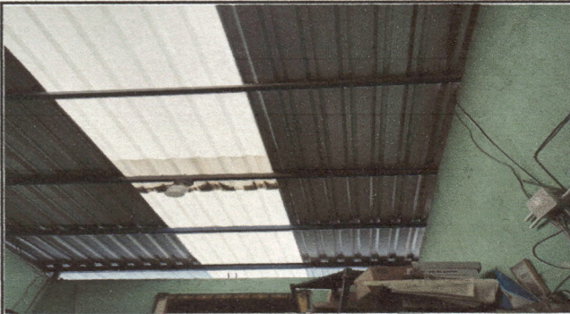
Foto7: SUSTITUCION DE CIELO FALSO
