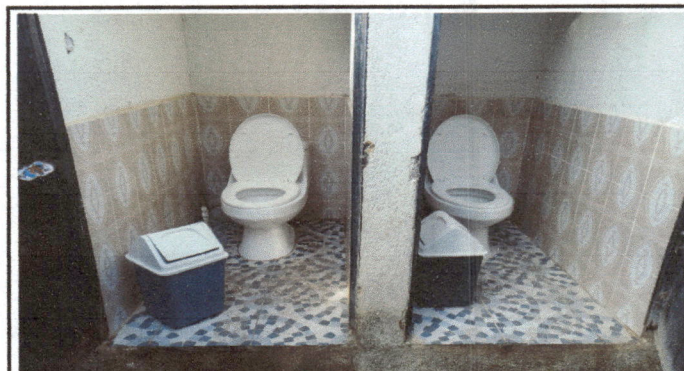
Foto 4: REPARACION DE SANITARIOS
