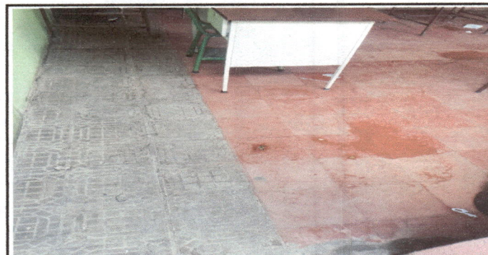
Foto 6: REPARACION DE PISO DE GRANITO
