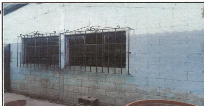
Foto 5: REPELLADO DE PARED
