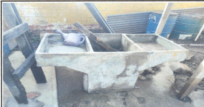
Foto1: SUSTITUCION DE PILA
