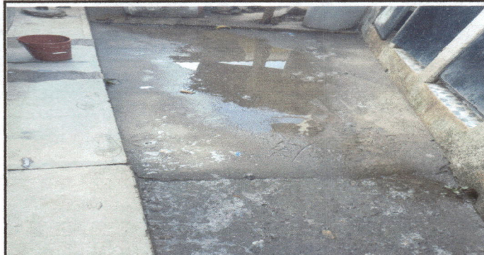
Foto 2: REPARACION DE PLANCHA DE CONCRETO DE PATIO
