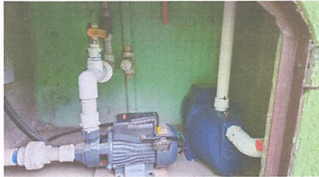
Foto 2: Colocación de nueva bomba de agua de 1 caballo de fuerza (color azul)
