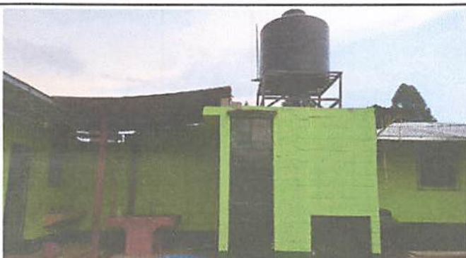
Foto 3: Impermeabilización, arreglo de pañuelos, base metálica y limpieza de tinaco
