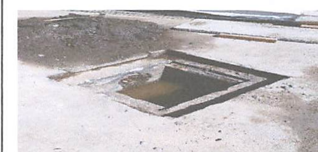
Foto 6: Limpieza de drenaje
