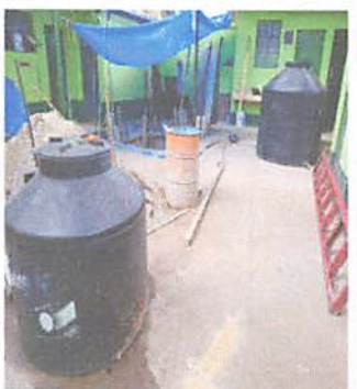
Foto 3: Tinacos abajo para impermeabilización de base.
