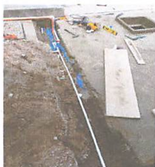
Foto 5: Fabricación de base metálica para tinaco e introducción de tubería nueva para cisterna y tinaco.
