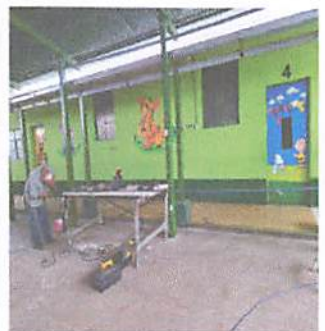
Foto 5: Fabricación de base metálica para tinaco e introducción de tubería nueva para cisterna y tinaco.
