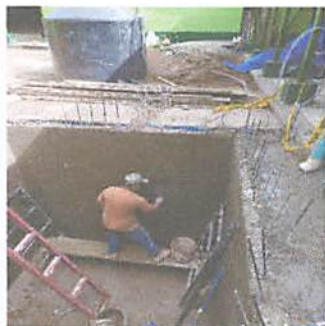
Foto1: Cisterna en proceso
