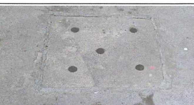
Foto 6: Reposadera insuficiente
