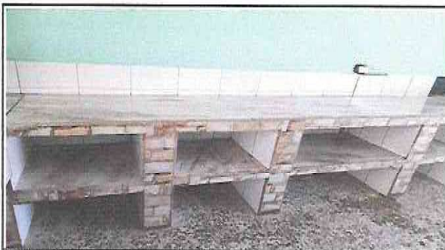
Instalación de azulejos y realización de pila para el área de cocina
