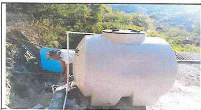
Sustitución de accesorios de depósito de agua (rotoplast)
