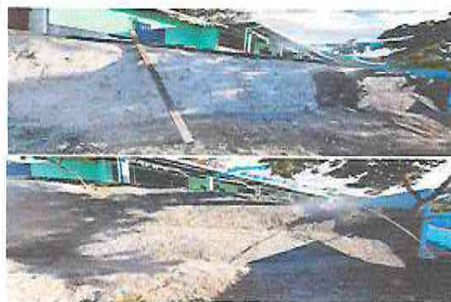
Protección de talud con electromeomaya y recubrimiento de concreto
