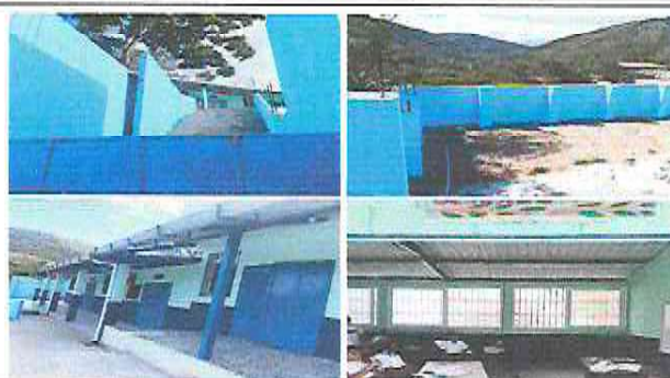
pintura en muros exteriores e interiores y en aulas
