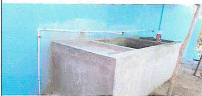
red de agua potable, sustitución de tubería línea principal
